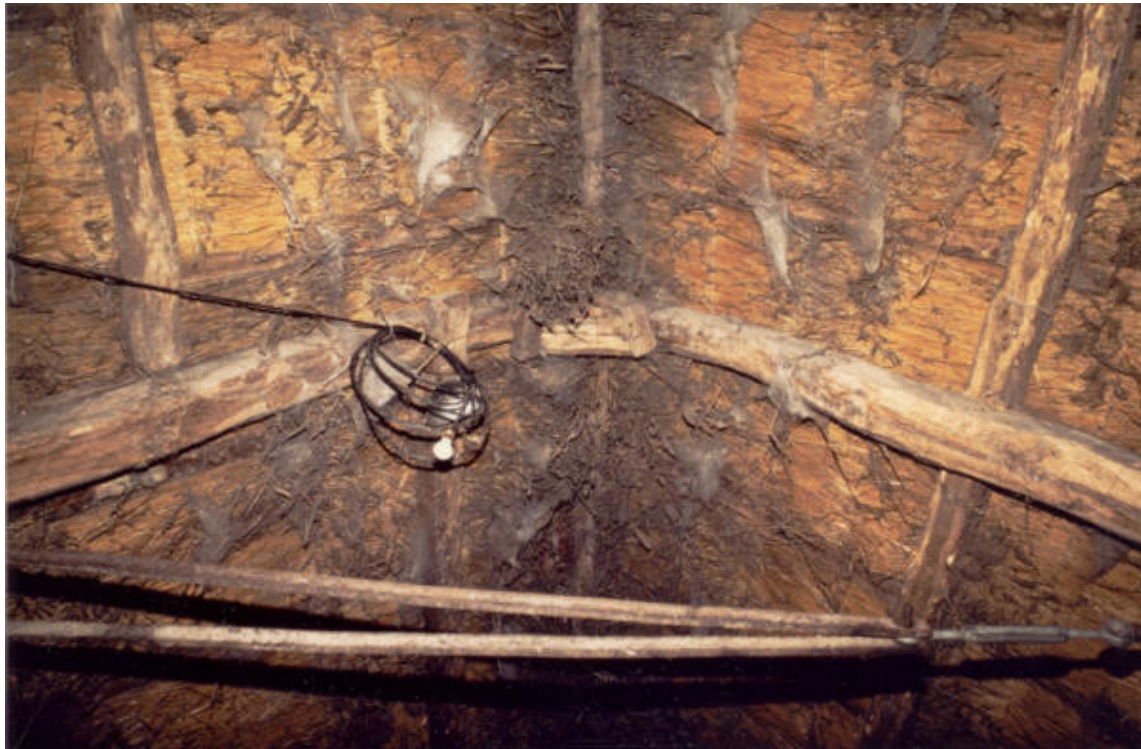
Le tiers supérieur du couple d'arbalétriers en F1 avec son entrait-tirant en fer et, sous le joug, un minuscule entrait relevé cloué.
