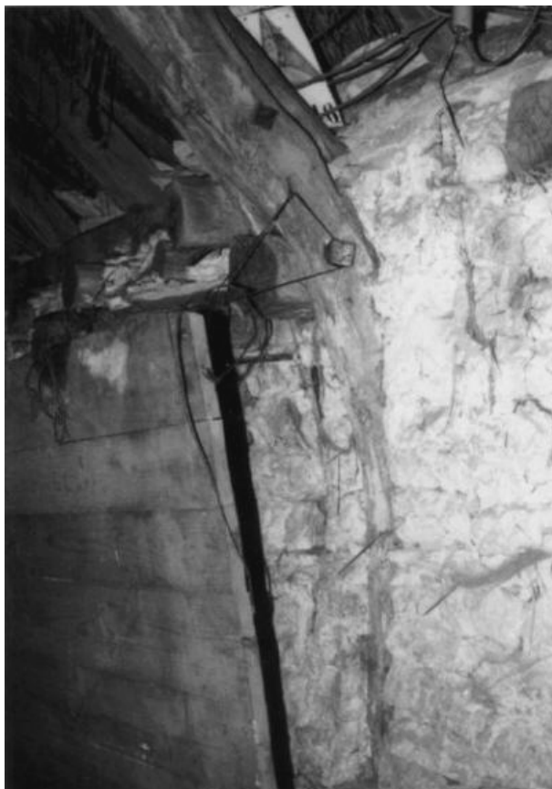
L'arbalétrier de droite en F1 avec sa moise boulonnée
