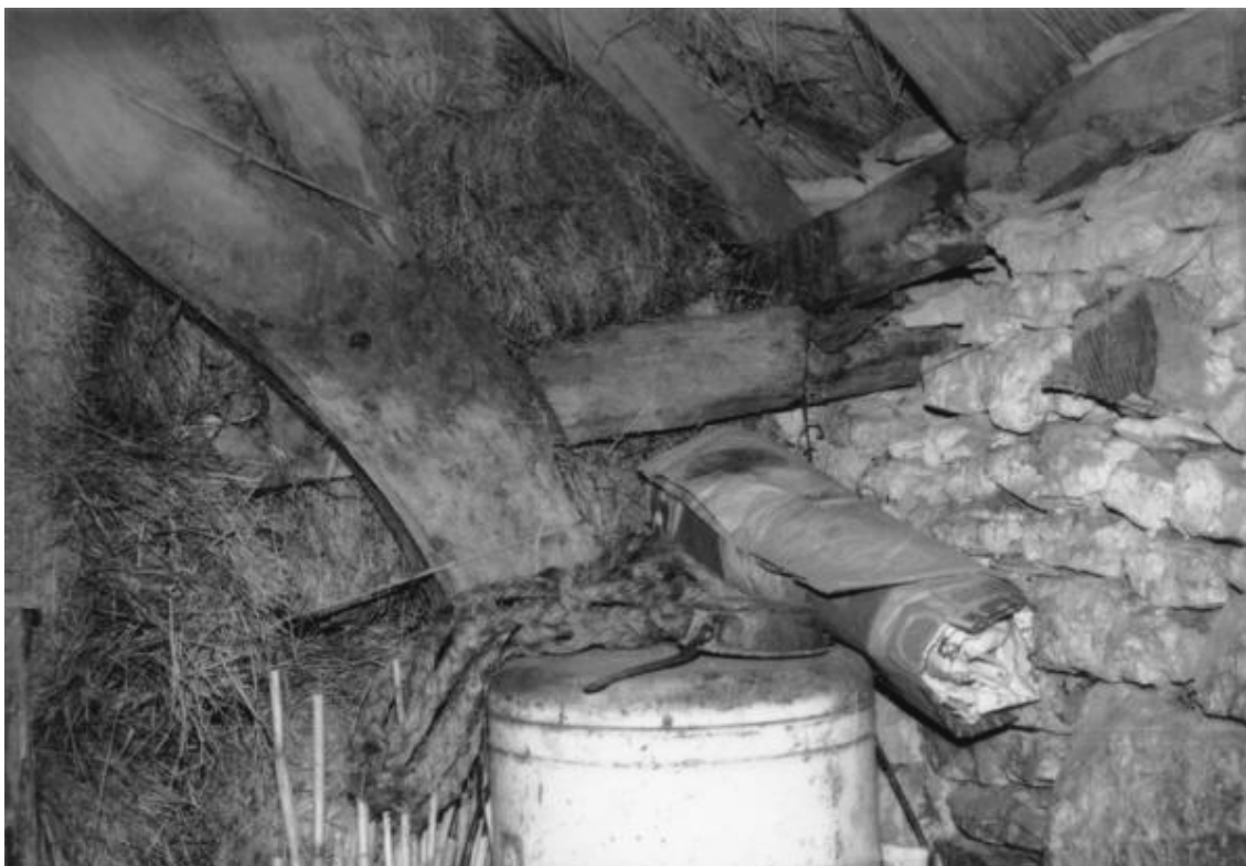
Dissimulée par tout un fatras, l'arbalétrier de droite en F2 avec son blochet.
