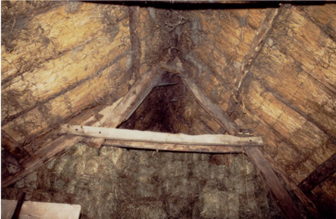
Le couple d'arbalétriers en F2, ou ce qu'il en reste après sectionnement de la partie inférieure de l'arbalétrier de gauche.
