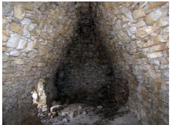
Vue intérieure Sud-Nord
