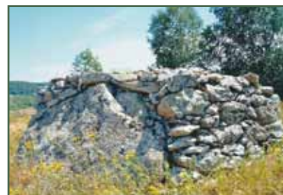
Aquí podem veure la gran roca de granit que forma la paret del darrere de la barraca
