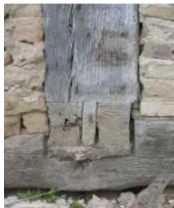
Assemblage à tenon et mortaise (scié)
