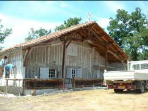
Enduit et badigeon à la chaux
