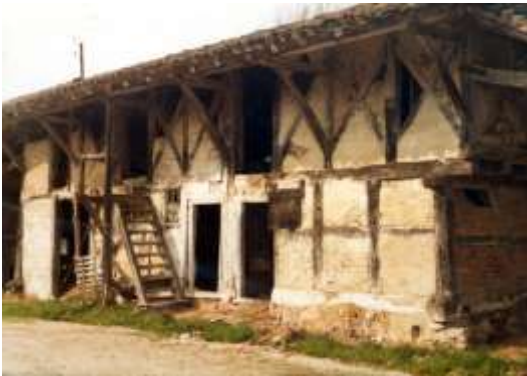
La ferme des Mangettes avant travaux
