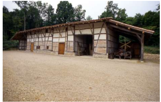
La Claison après travaux
