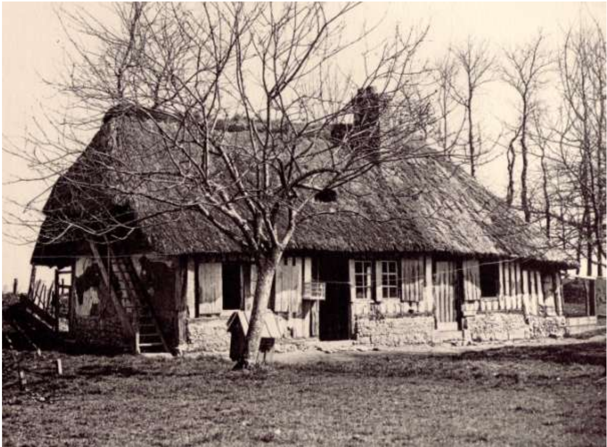
Fig. 3 : Chaumière du pays de Caux, à colombage vertical serré. Les Trois-Pierres (Seine-Maritime). Cl. R. Quenedey, Les Provinces de l'ancienne France, La Normandie, t. I : Seine-Maritime, 1927, pl. 1.
