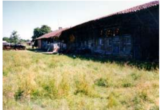
La Claison avant travaux
