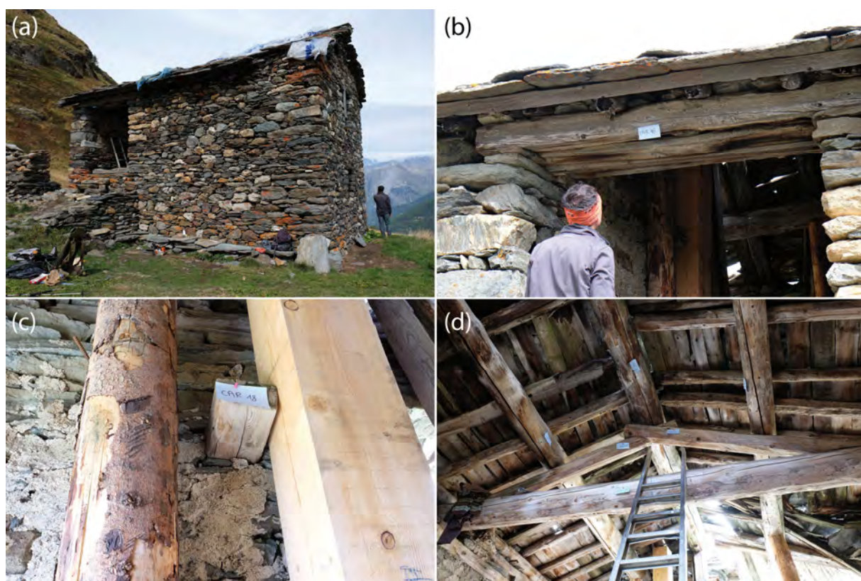
Fig. 9. Chalet du Carroley (a) Vue d'ensemble de la façade Sud (b) Linteau de la porte en façade Sud (CAR16, datation : 1721+) ; (c) Pièce maçonnée dans le pignon Ouest intérieur (CAR18, datation : 1632+) ; (d) Ferme et pannes échantillonnées (datation de l'ensemble : 1868). Les deux arbalétriers (CAR10 et 11) proviennent du même arbre.
