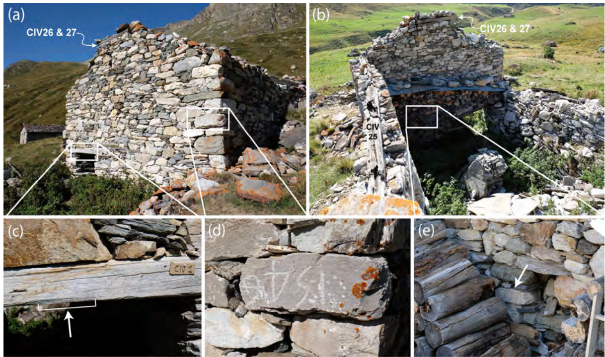
Fig. 2. Ruine à La Civière (a) Vue d'ensemble du pignon Sud-Est ; (b) Vue vers le Sud-Est depuis le mur Nord. Le tas de bois échantillonné est au dos du pignon ; inscriptions datantes (c) '1471' ; (d) '1546' retournée ; (e) '1666' retournée.
