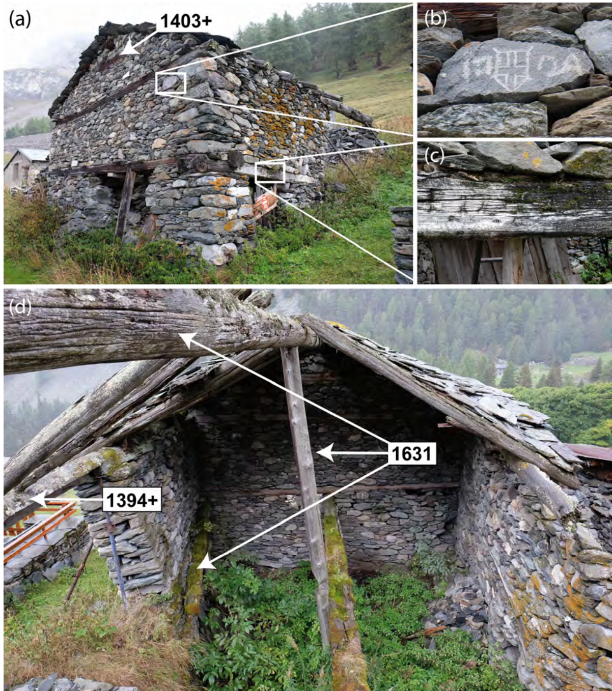
Fig. 5. Grange de Polset (a) Vue d'ensemble du pignon Ouest et de la façade Sud avec la localisation des inscriptions datantes ; (b) inscription '1724' avec le blason de la Savoie ; (c) inscription '1724' sur le linteau où a été prélevé l'échantillon POL03 ; (d) Vue du bâtiment depuis l'amont, à l'extrémité Est de la panne faîtière. Les datations des pièces de rempli sont indiquées.
