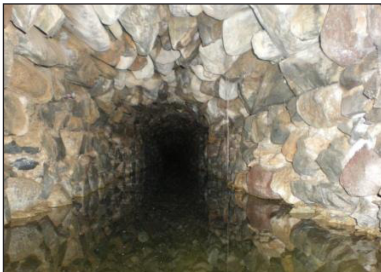
Detall de mina amb galeria de volta. Foto: Lluís Fernández Alcantara
