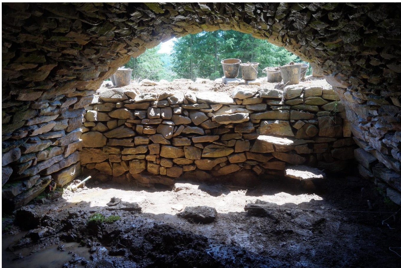
Fig. 1 : l'intérieur de l'écluse lors de sa restauration.
