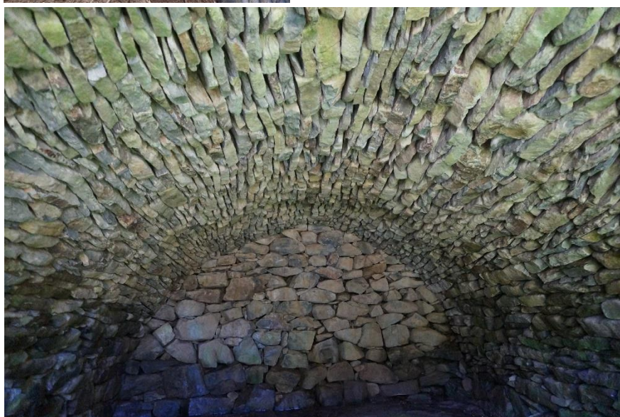
Fig. 48 : vue de l'appareillage de l'intrados et du mur du fond
