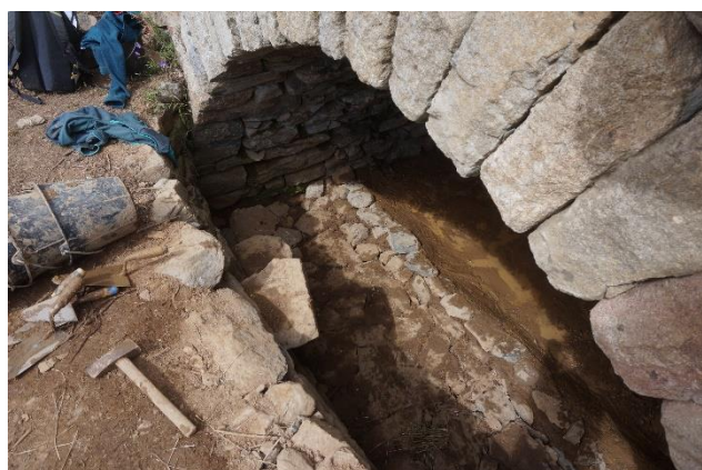
Fig. 3 : Voûte en moellons de granit taillés, écluse bassin du Jardin Clos du Pré Nouveau.
