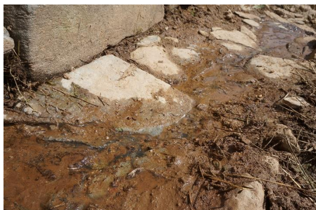
Ci-dessous. Fig. 33 : pente d'écoulement à droite. Au premier plan, la dalle de recouvrement du départ de l'exutoire pour le trop-plein. Fig. 34 : détail de la calade.
