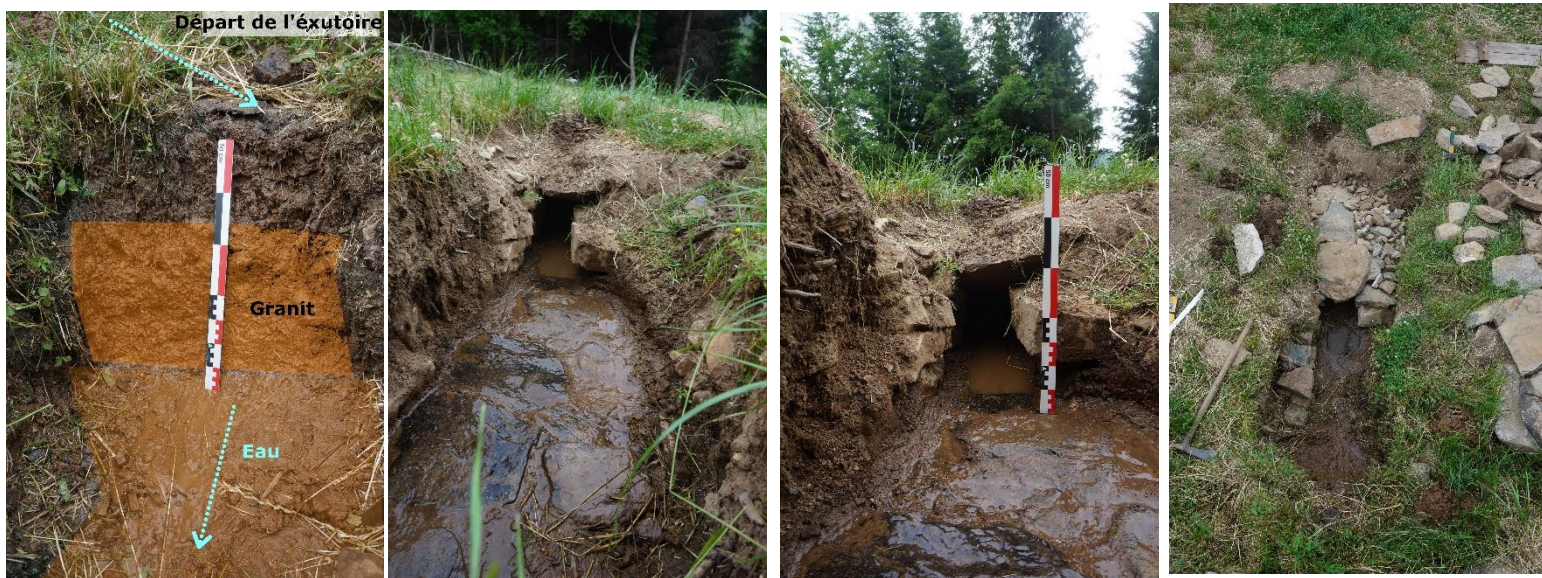
Fig. 35 à 38 : Vues de l'arjaille lors de sa restauration - terrassement du granit - coupe constructive - vue dessus.
