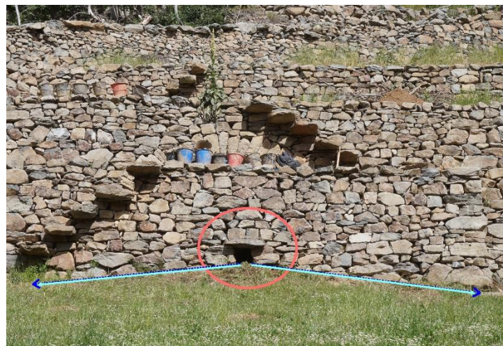
Fig. 30 : écoulement de l'eau hors du mur accès
