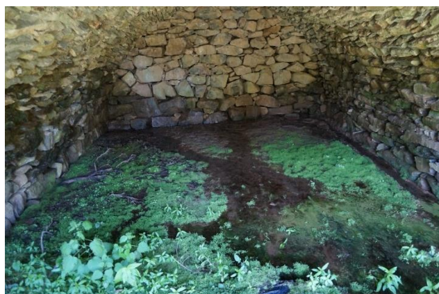
Fig. 6 : Ouvrages urbains voûtés liés aux chemins de l'eau, hameau de Mons (© Monique Gadais).
