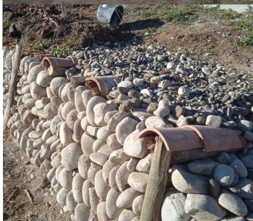
Fig. 26 : le mur et son drain arrière avant re-terrassement et talutage
