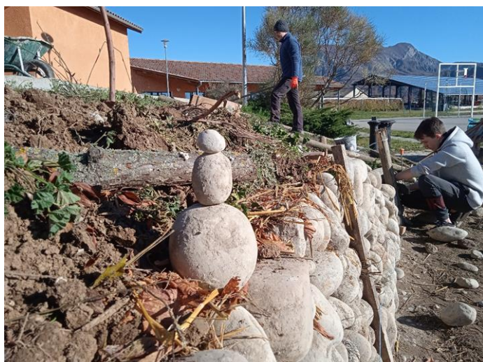
Fig. 20 à 23 : l'action d'appareiller et les dispositifs dans le mur
