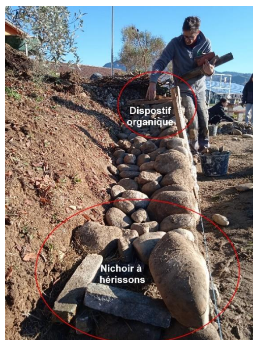
Fig. 20 à 23 : l'action d'appareiller et les dispositifs dans le mur
