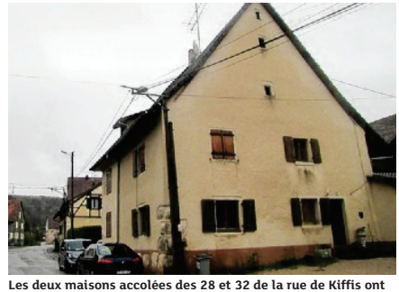
Les deux maisons accolées des 28 et 32 de la rue de Kiffis ont construites en 1547.
