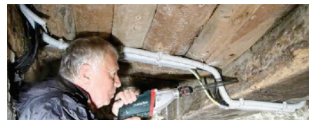
Burghart Schmidt forer une poutre en chêne dans la cave.
