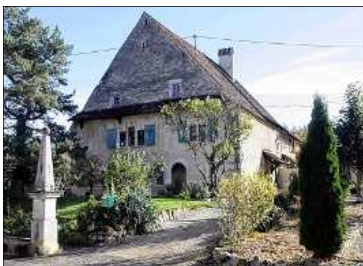
L'ancien tribunal de Lutter : c'est le seul édifice du village inscrit à l'inventaire des monuments historiques depuis 1987. Il a été complètement restauré entre 1972 et 1975 par les chantiers de bénévoles organisés par l'association Maisons paysannes d'Alsace, sous la conduite de Marc Grodwohl.
