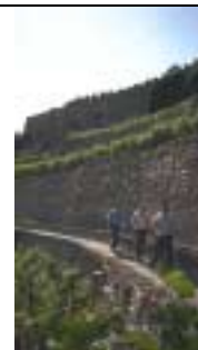
Ouvrage d'art - Clavaux
