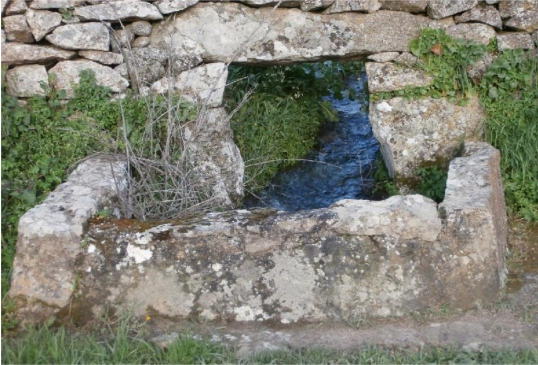
Otra vista de la pequeña ingeniería que hemos visto antes. Se aprecia bien la abertura en el muro para permitir a la corriente, aunque vaya muy crecida, pasar sin dañarlo y el brocal del sifón realizado con tres piezas de cantería que evita posibles accidentes de transeúntes .
