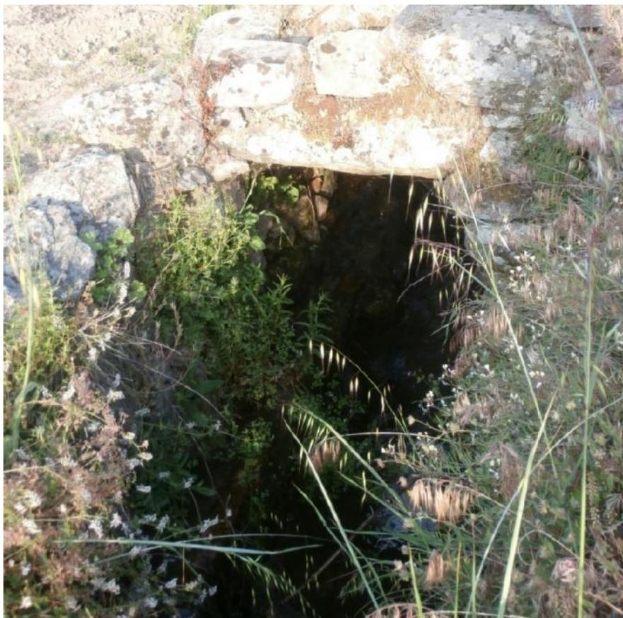
El cauce se ha excavado profundamente porque atraviesa una huerta junto al Camino del Castañar y se han reforzado los laterales con paredes de piedra .Se ha construido un puentecillo formado por una gran losa de granito con un pequeño pretil.
